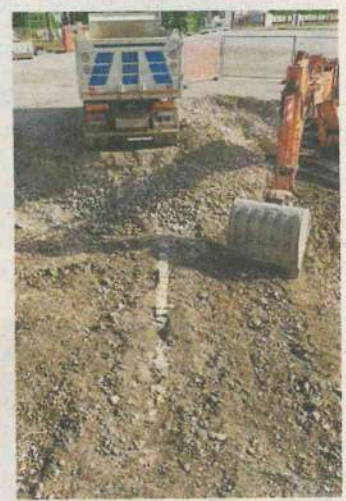
• Il muro nel cantiere alla Baltera
