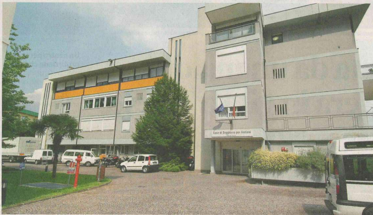
• La casa di riposo di Riva fra due anni potrà contare su 60 posti in più grazie all'ampliamento i cui lavori partono oggi
