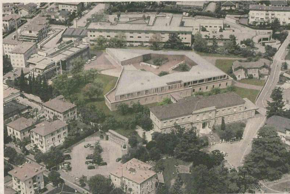
Il rendering della Cittadella dell'accoglienza, che verrà realizzata dove oggi sorge l'ex ospedale di Riva
